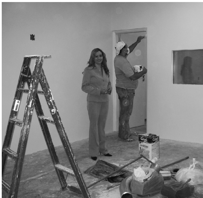
Acabamento da sala onde será instalado o tomógrafo
