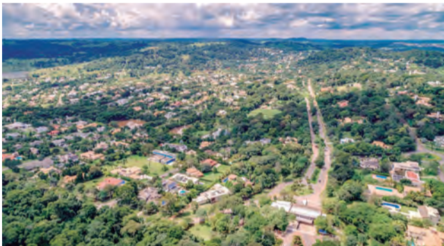
Residencial Aldeia do Vale, em Goiânia, instala bacias de contenção com caixas de infiltração para captação de água das chuvas
