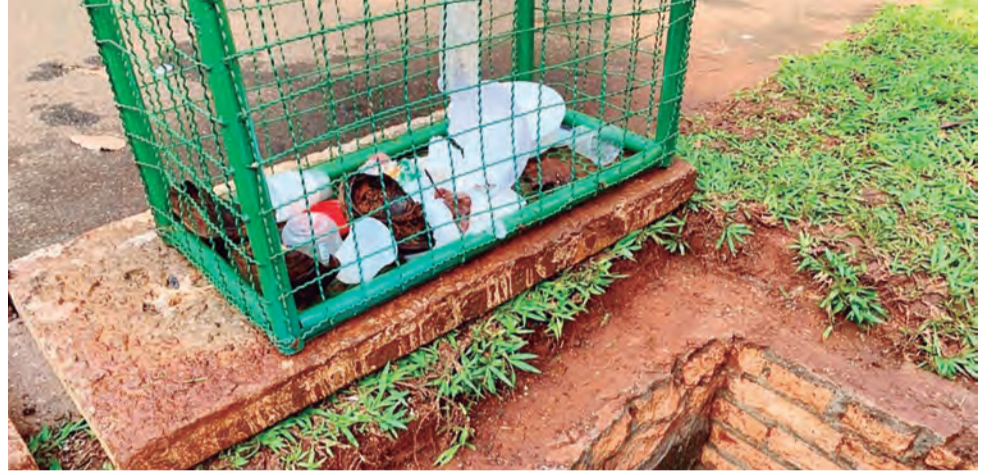
Cesto de metal do bueiro inteligente desenvolvido pela Prefeitura de Goiânia (AMMA)
