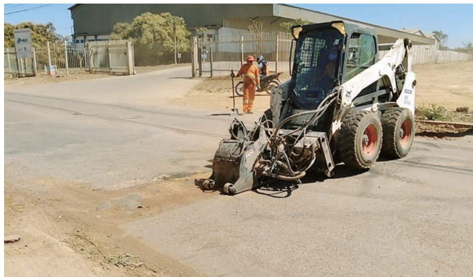
Rodovia GO-577, recém-estadualizada, já recebe equipes da Goinfra para obras de recapeamento da via
