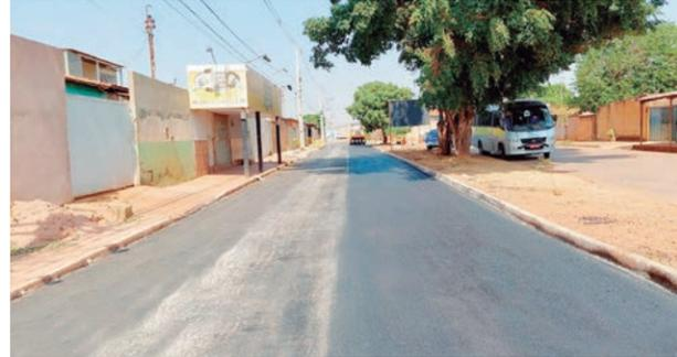
por reparos localizados em toda a sua extensão, inclusive com a recuperação da erosão às margens da pista, antes da aplicação da nova capa asfáltica em concreto betuminoso usinado a quente (CBUQ). Rota turística de acesso ao Lago Corumbá IV e às belezas naturais da região, a rodovia vai beneficiar cerca de 250 mil moradores de Valparaíso e Novo Gama, e ainda fomentar o turismo e a economia em Goiás.
