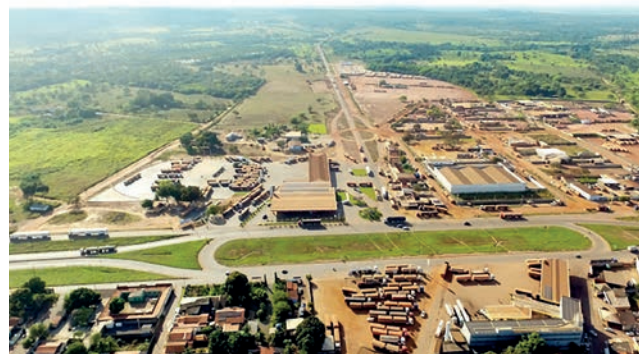
Obras de recuperação asfáltica já iniciaram na TO-335, localizada no município de Colinas do Tocantins
