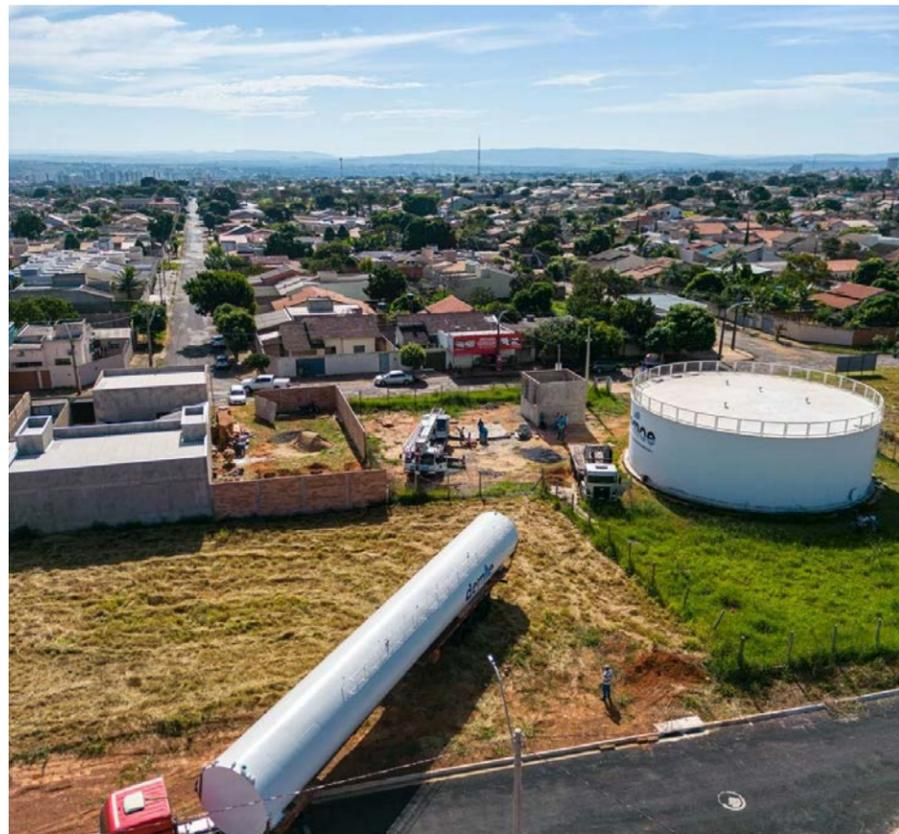
O Departamento Municipal de Água e Esgoto (Demae) de Caldas Novas instalou um reservatório elevado no Setor Jardim Serrano, que possui 28 metros e capacidade de 450 mil litros de armazenamento.
