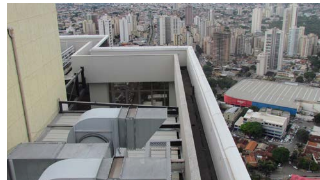
Canaletas que captam e encaminham a água das chuvas para reservatórios
